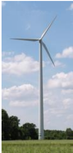
Windkraftanlage Quelle: BGR
